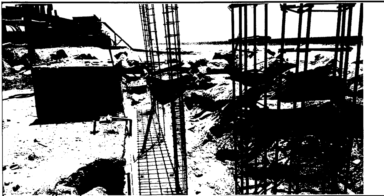
FOTO N° 10 VISTA COLOCACION DE ACERO EN ZAPATAS Y MURO DE CONCRETO TRAMO 3LADO IZQUIERDO.
