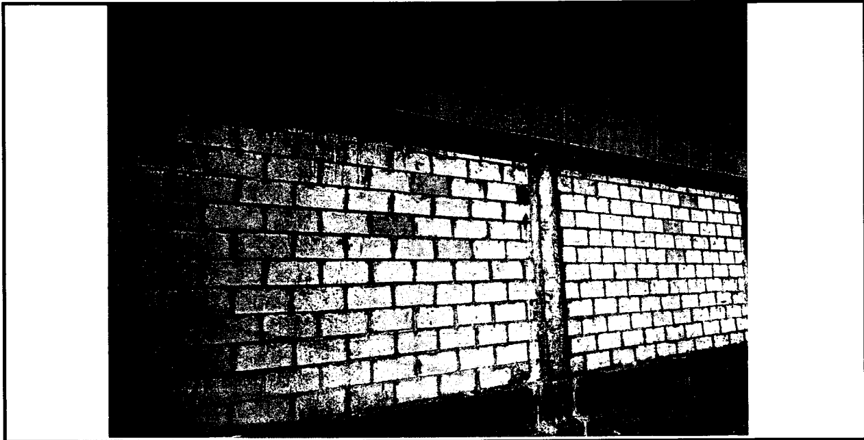
FOTO N° 7 VISTA CERCO PERIMETRICO Y VIGA SOLERA TRAMO 4.
