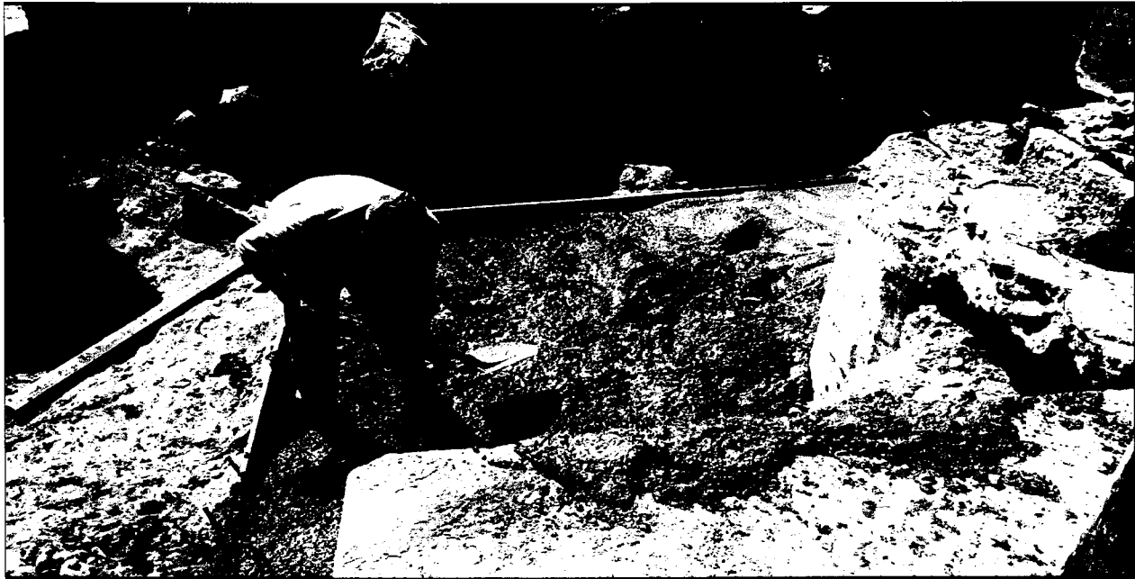
FOTO N° 2 VISTA VACEADO DE SOLADO TRAMO 2
